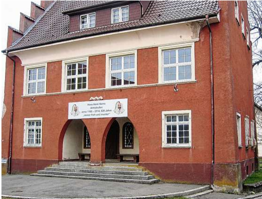
Das „Rote Rathaus“ vor der Sanierung: Die marode Stützmauer und der Baum (rechts) fallen den überarbeiteten Außenanlagen zum Opfer. Ein Ersatzbaum wird neu gepflanzt. BILD: JÜRGEN MÜLLER
