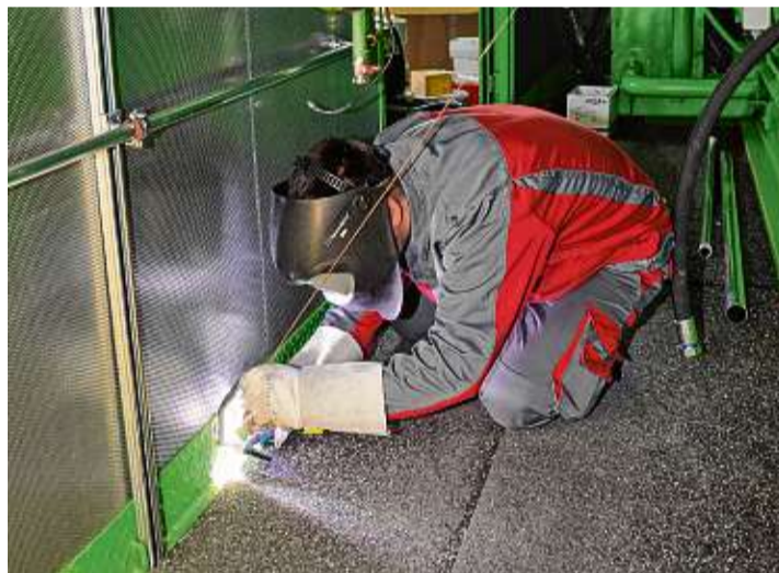
Mitarbeiter Alan Felic schweißt im Container mit einem speziellen Schweißverfahren die Haltebügel für den Transport der Anlage an.
