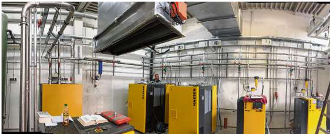
Zu den Kunden von Rolf Hauptvogel gehört die Firma Frei-Lacke in Döggingen, wo unter anderem der Kompressorraum saniert worden ist.
