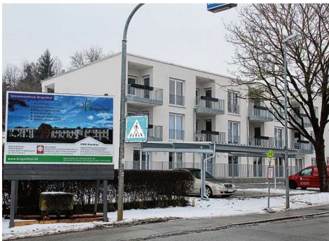
Nach eineinhalb Jahren Bauzeit ist das Seniorenzentrum Brigachtal an der Marbacher Straße fertig. Zu sehen ist hier das Haus Nord. BILD: TOBIAS LANGE
