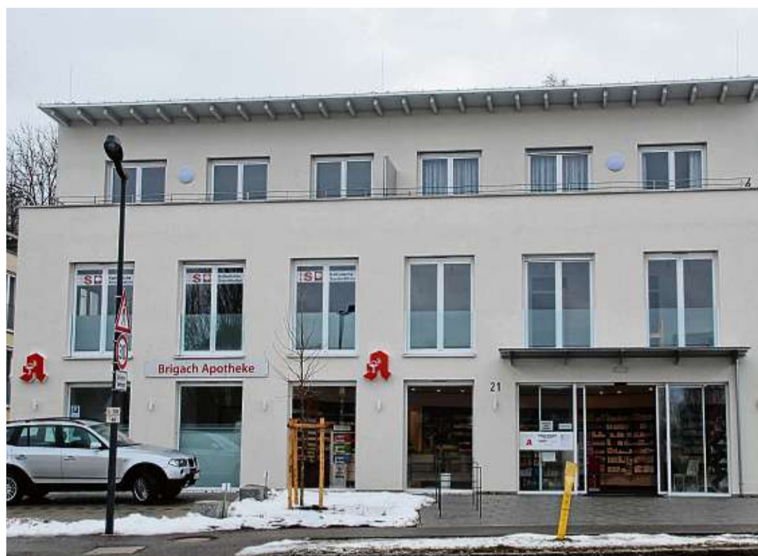
Im neu errichteten Haus Süd ist die Brigach Apotheke eingezogen. Auch die Katholische Sozialstation hat hier neue Räume gefunden. BILD: TOBIAS LANGE
